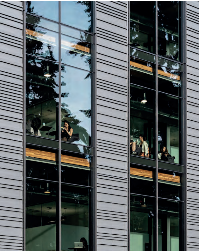
Door het glas is de houten constructie zichtbaar.
