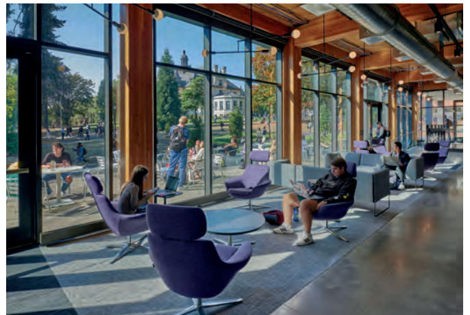
Omdat de architecten het hout niet wilden afdekken, zijn alle leidingen zichtbaar.
